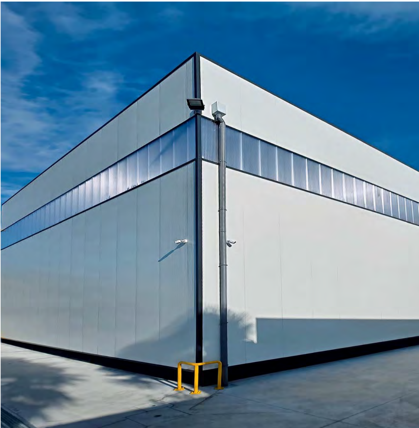
Neues Gebäude für AIV-Bearbeitungslösung in Gondomar, PT
